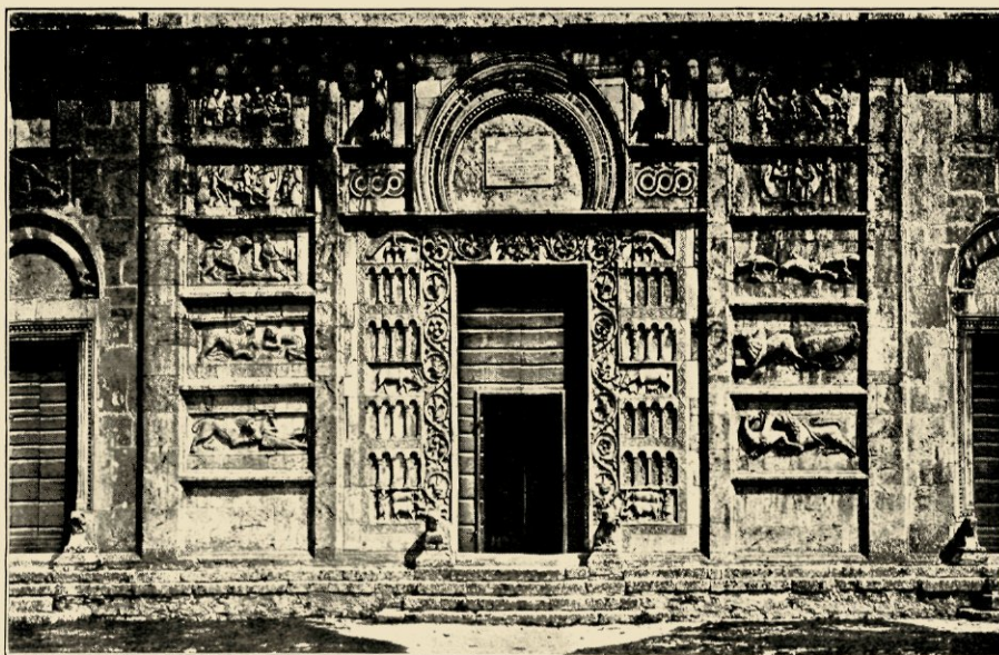
AFB. 7. ONDERSTE GEDEELTE VAN DE FAÇADE VAN SAN PIETRO (FOTO ANDERSON).
