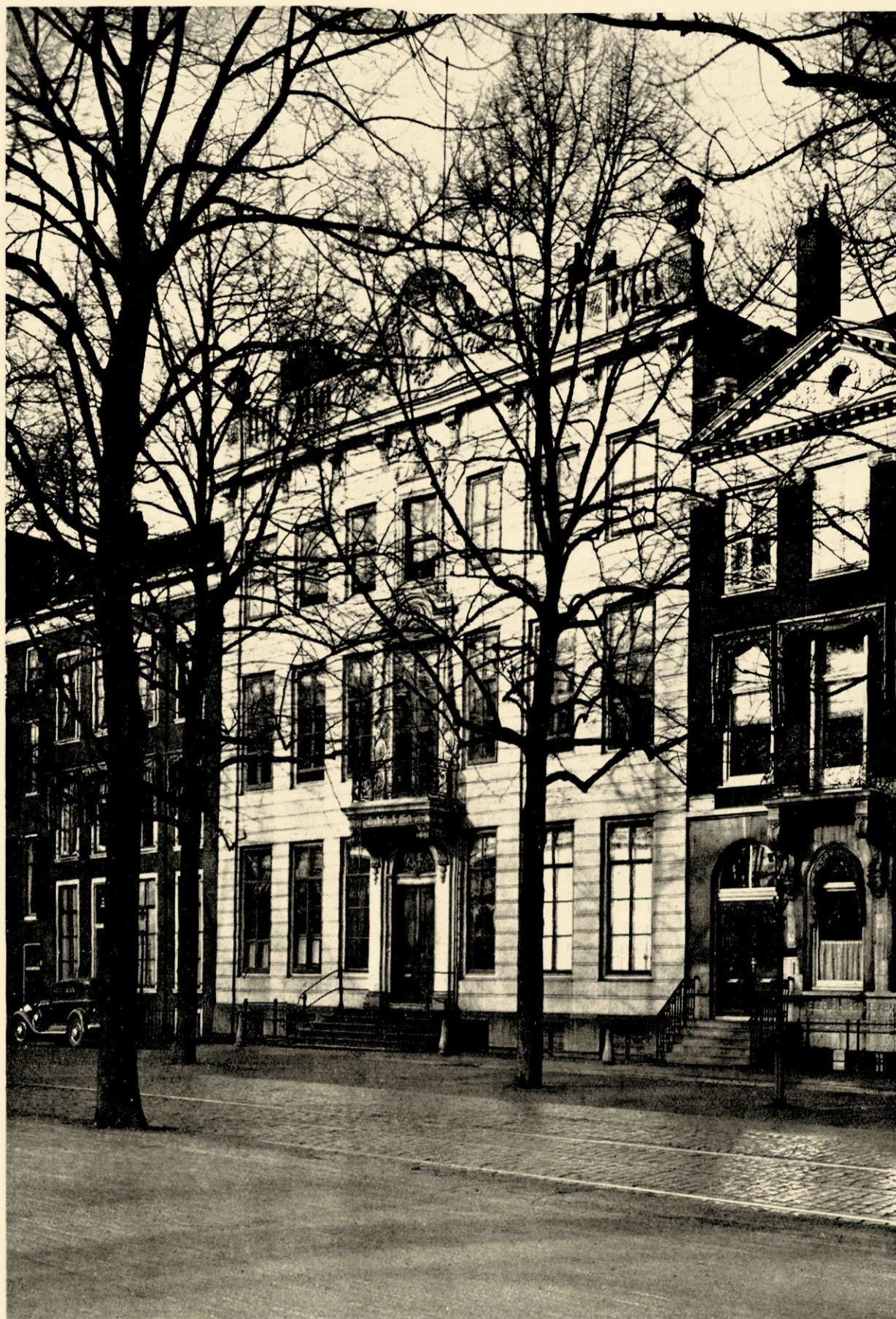
AFB. 2. GEVEL VAN HET HUIS LANGE VIJVERBERG 8 TE 'S-GRAVENHAGE
